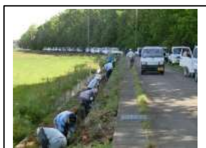
( 水路の泥上げ )
